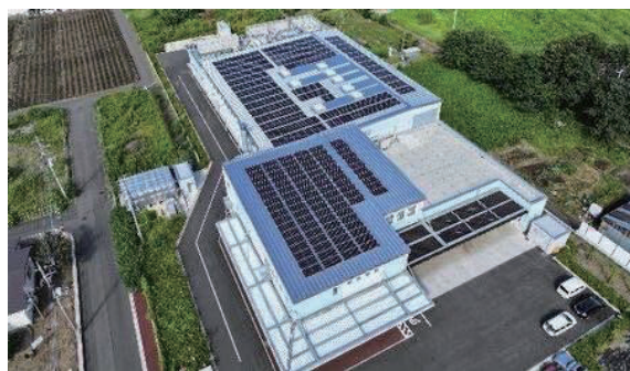
給食センターの屋上に設置された太陽光発電パネル
