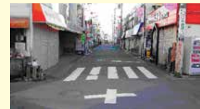
和ヶ原商店街の消えかかっていた横断歩道ラインの書き直し
