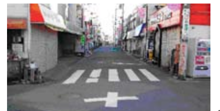
和ヶ原商店街の消えかかっていた横断歩道ラインの書き直し
